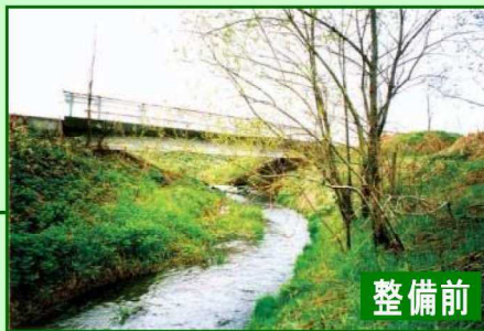
排水路の整備
