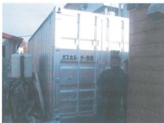
大きな風船状の容器が入っているガス貯留設備
