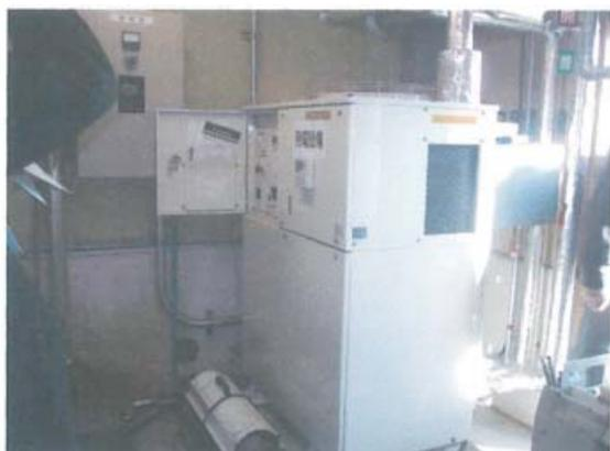
発酵槽関連設備と接続している発電設備 60%がメタンガス、ここから水素を取り出す。
