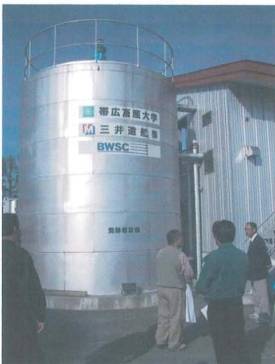
150 m<sup>3</sup>の発酵槽でバイオマスを採取し、148 kWの電力を発生させる。うちバイオマス設備で 40 kW、余剰分 100 kW 4 人家族の家屋 10 軒分をまかなえる。
