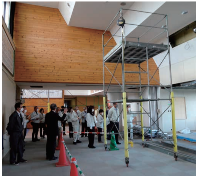
整備が進むサテライトオフィス (旧昭和小学校)
